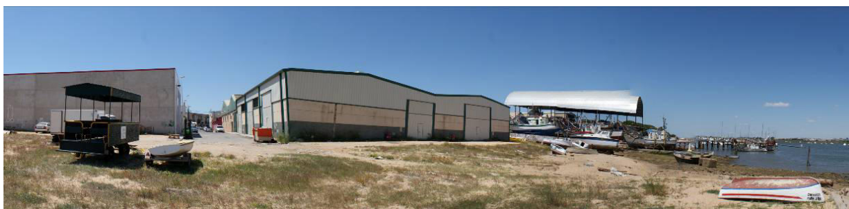
Traseras de las naves localizadas en el Pasaje de los Varaderos (2012)
