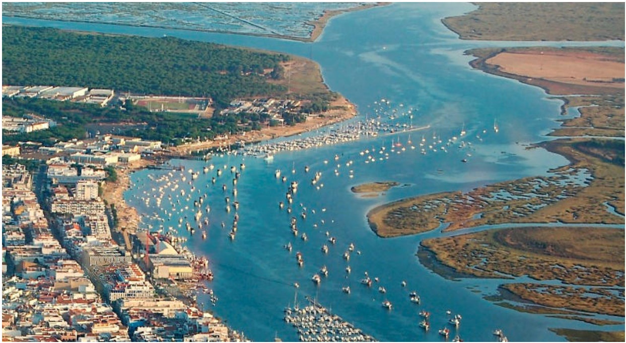
Vista del interior de la ría (2010)
