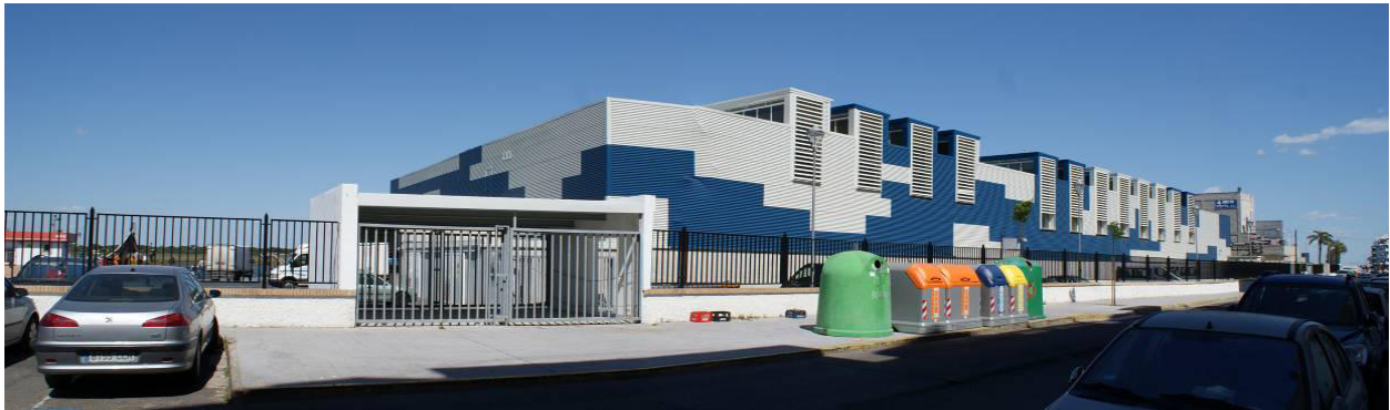
Edificio de comercialización de la pesca (2012)
