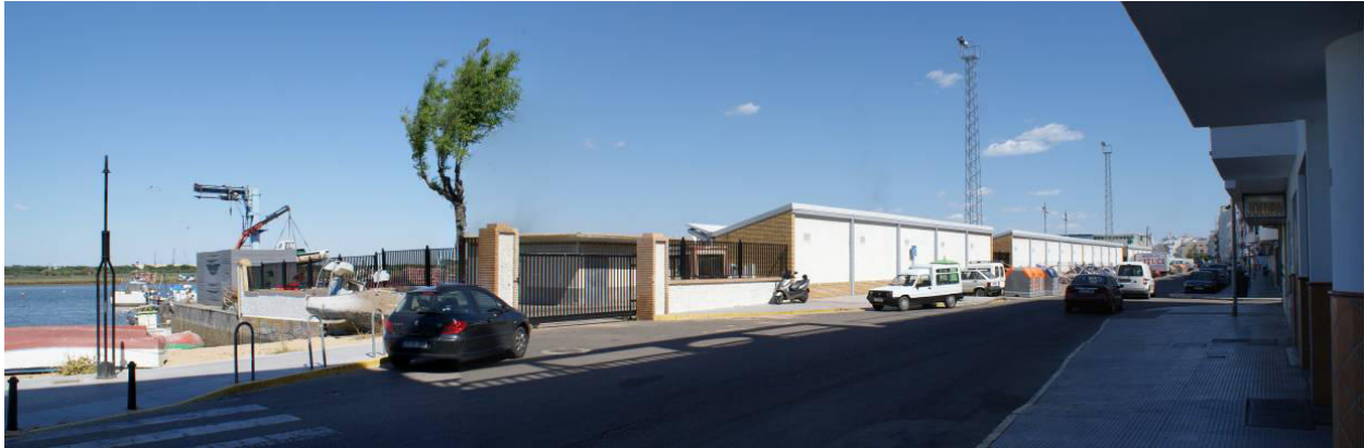
Instalaciones pesqueras en el Paseo de la Ría (2012)
