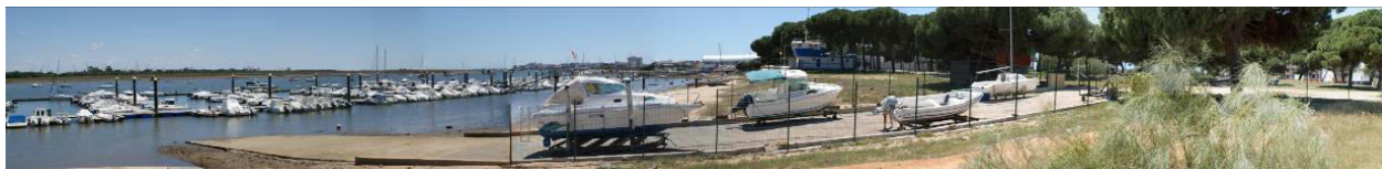
Rampa sin armar localizada en el entorno de La Peguera (2012)
